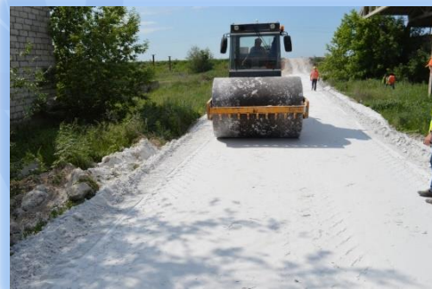
Уплотнение слоя фосфогипса дорожного
