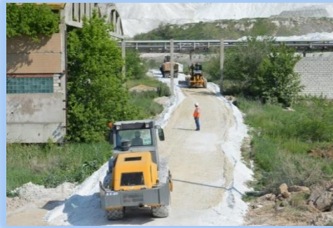
Распределение и уплотнение щебня на слой фосфогипса
