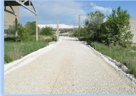
Дорога на территории предприятия готова к эксплуатации
