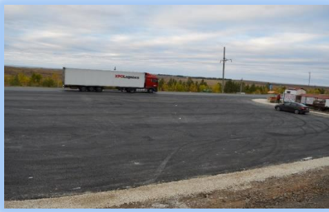
На уплотненный щебень распределяется асфальто-бетонная крошка
