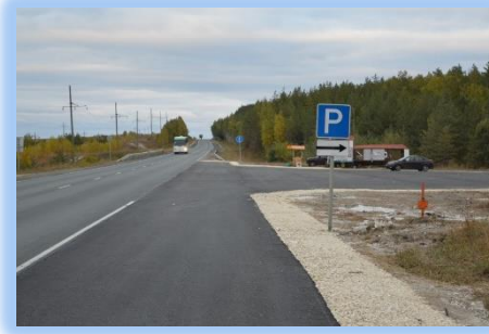
Участок дороги построен и эксплуатируется
