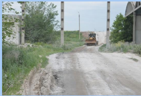
Разравнивание фосфогипса дорожного
