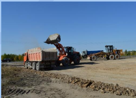
Планировка и уплотнение поверхности земляного полотна
