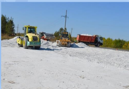
Разравнивание, планировка и уплотнение слоя фосфогипса дорожного
