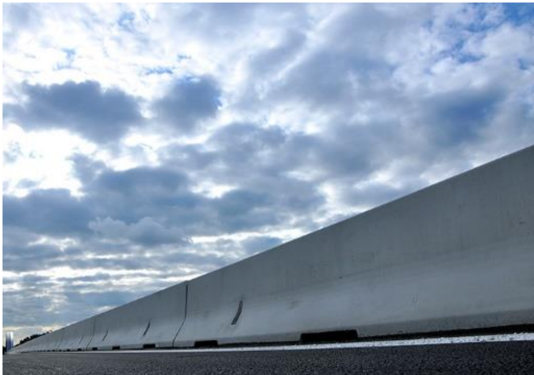
Цементобетонное барьерное ограждение
