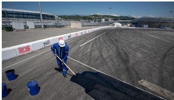
Нанесение ЗВС на автодроме в Сочи
