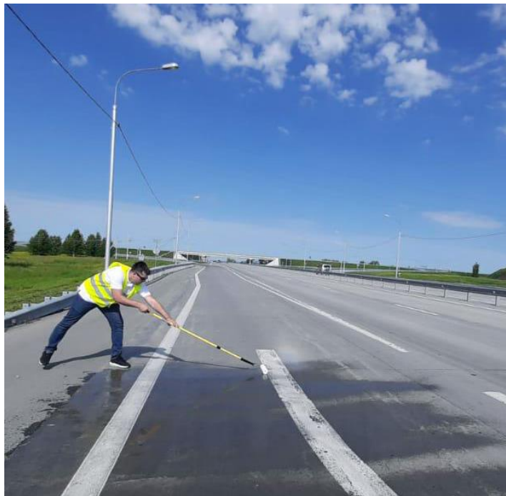
Опытное применение пропитки «БРИТ» на участке с цементобетонным покрытием
